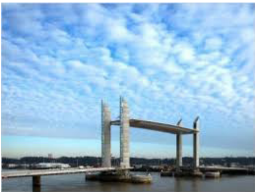
Le nouveau pont Chaban-Delmas :
